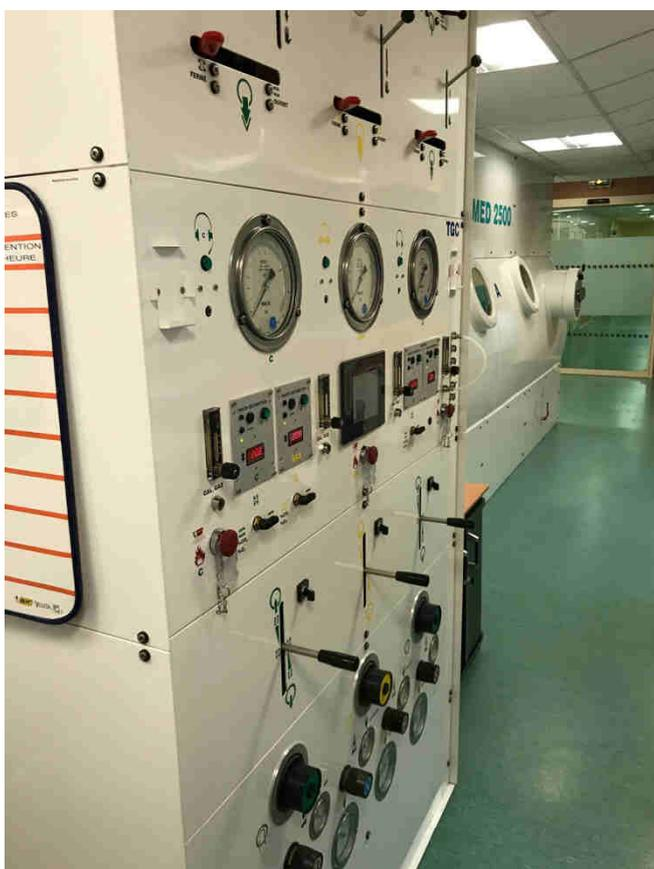
**Fig 4 : poste de contrôle manuel (utilisation en secours)**
